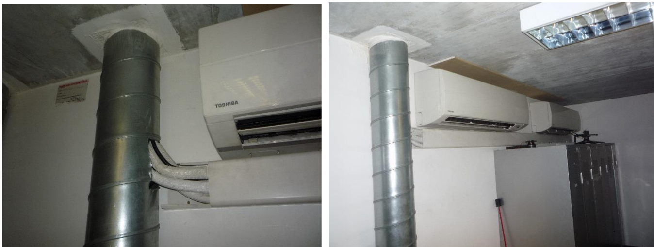
Potrubí chladiva a komunikační kabeláž přichází do 6.NP v kovové chráničce. Vpravo pohled na stávající vnitřní nástěnné jednotky.
