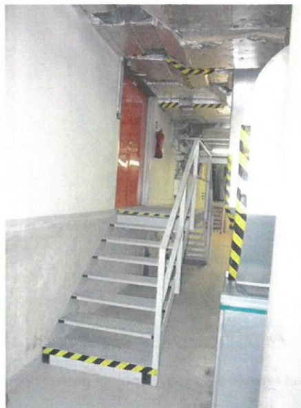
Odstup VZT jednotky od schodů, transportní cesta směrem ze/do strojovny VZT
