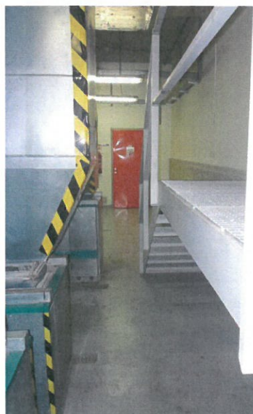
Odstup VZT jednotky od schodů, transportní cesta směrem ze/do strojovny VZT
