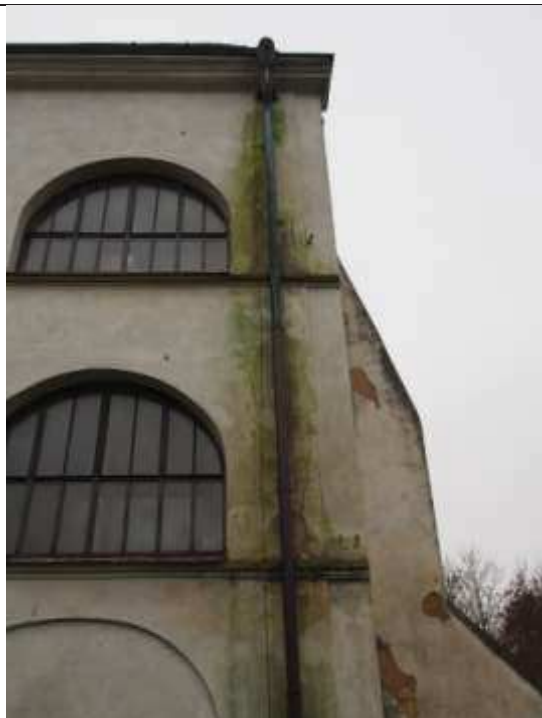
Obr. 28 a 29: Poškození zatékající vodou severní fasáda jižního křídla a stav opěrných pilířů na západní straně jižního křídla
