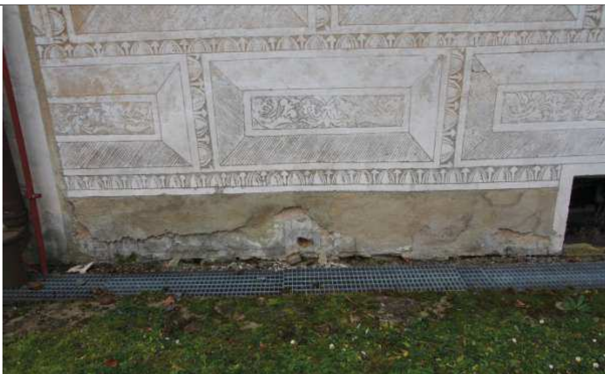
Obr. 9: Detail poškození v soklové části, patrné sgrafito pod druhotnou vrstvou – západní fasáda východního křídla
