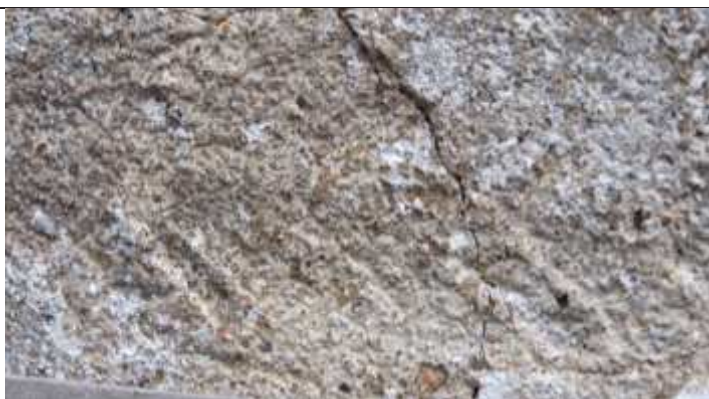
Obr. 13, 14 a 15: Poškození omítek a zvýšená salinita spodní partie levé části západní fasády východního křídla
