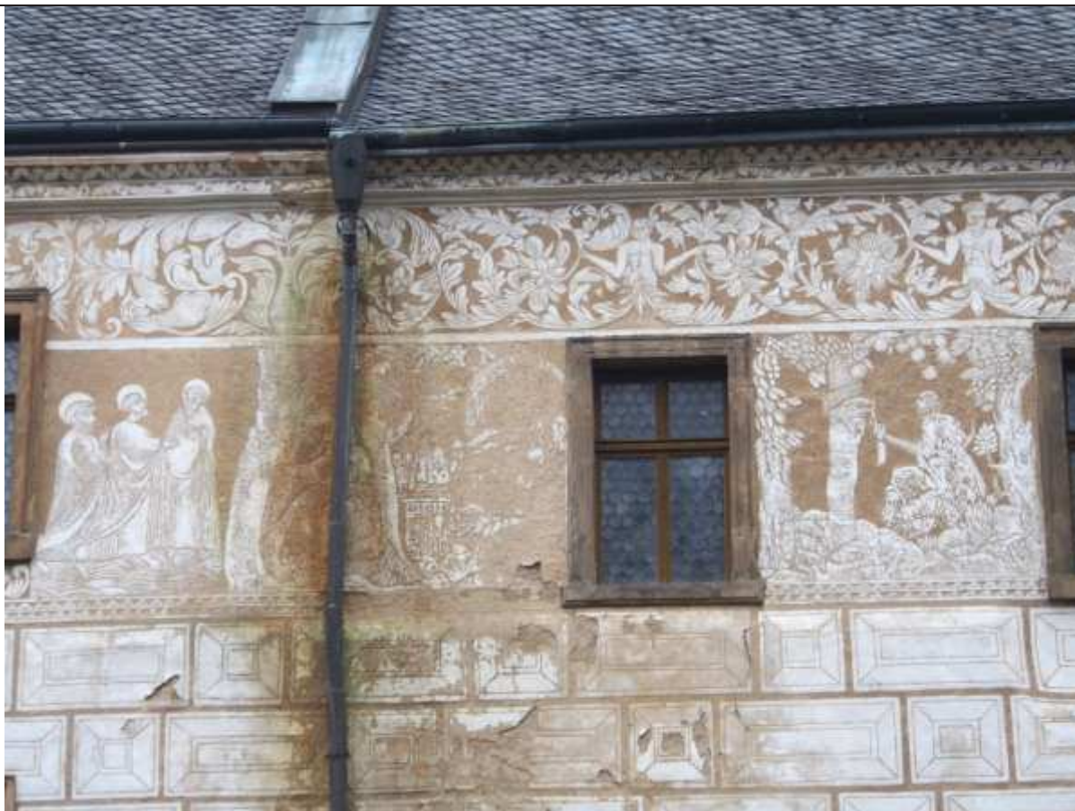
Obr. 32: Detail poškození sgrafit východní fasády východního křídla
