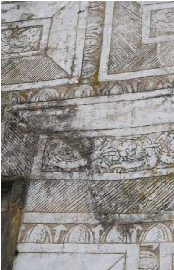
Obr. 10 a 11: Detail poškození sgrafita západní fasáda východního křídla
