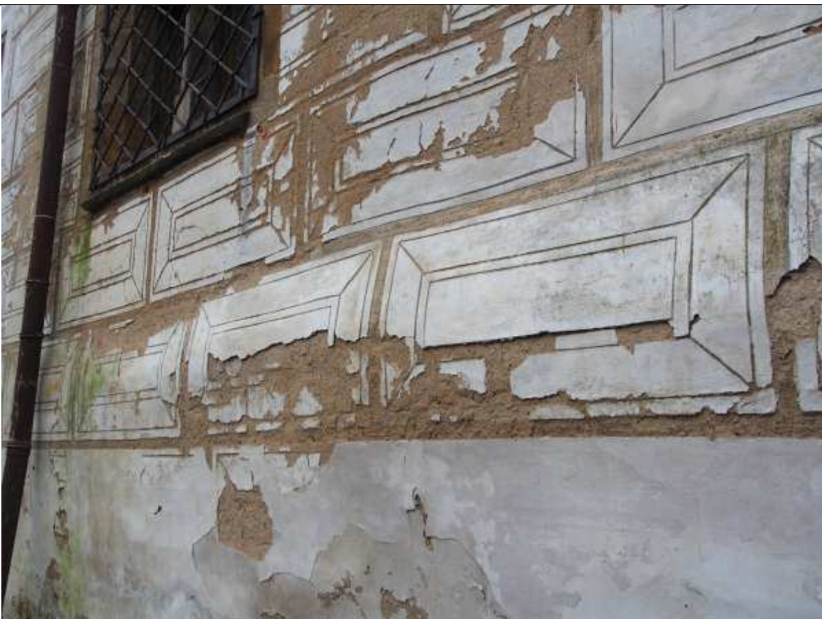
Obr. 33: Detail poškození sgrafit východní fasády východního křídla
