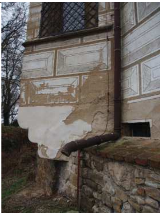
Obr. 41 a 42: Současný stav v soklových partiích a opěráků východní fasády východního křídla
