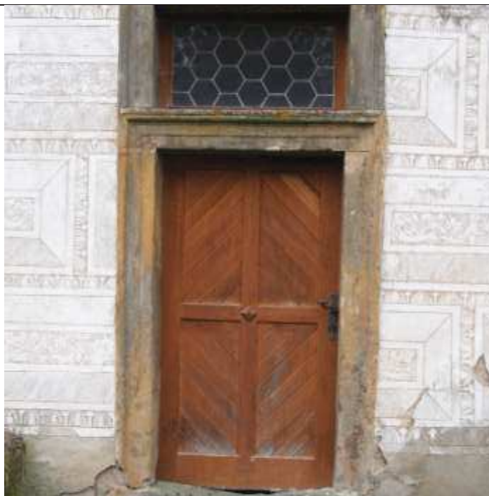
Obr. 17 a 18: Poškození portálu vlivem zvýšené vlhkosti – severní fasáda jižního křídla
