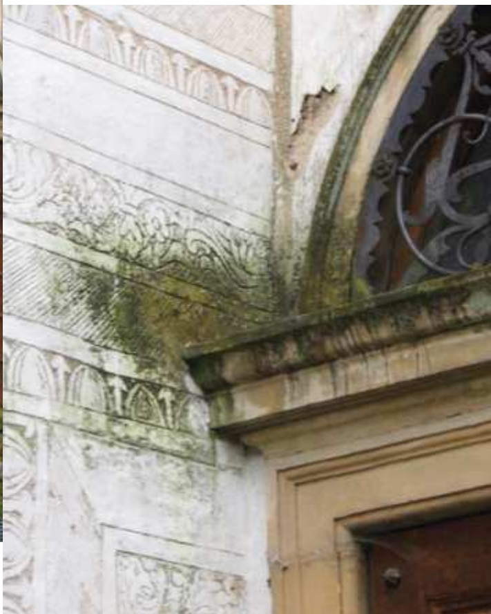
Obr. 17 a 18: Poškození portálu vlivem zvýšené vlhkosti – severní fasáda jižního křídla
