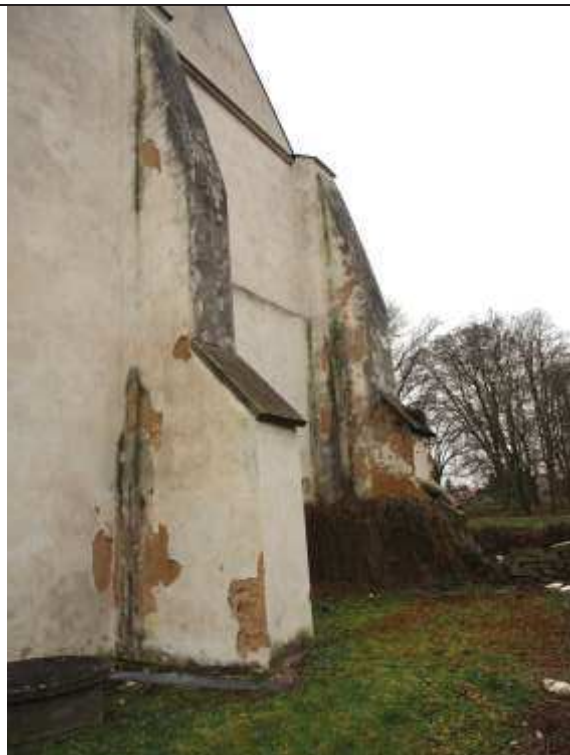
Obr. 28 a 29: Poškození zatékající vodou severní fasáda jižního křídla a stav opěrných pilířů na západní straně jižního křídla
