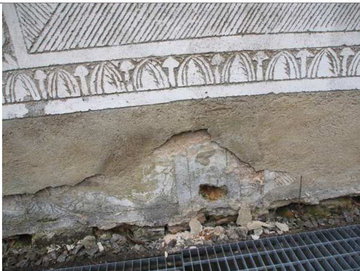
Obr. 16: detail staší vrstvy sgrafita v soklové části západní fasády východního křídla
