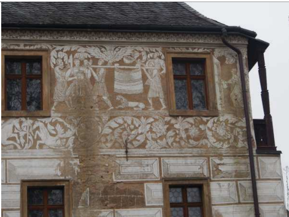
Obr. 39: Detail poškození sgrafit a odhalená gotická omítka východní fasády východního křídla
