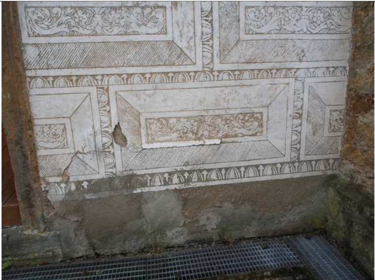
Obr. 12: Cementové vysprávký v soklové části západní fasády východního křídla
