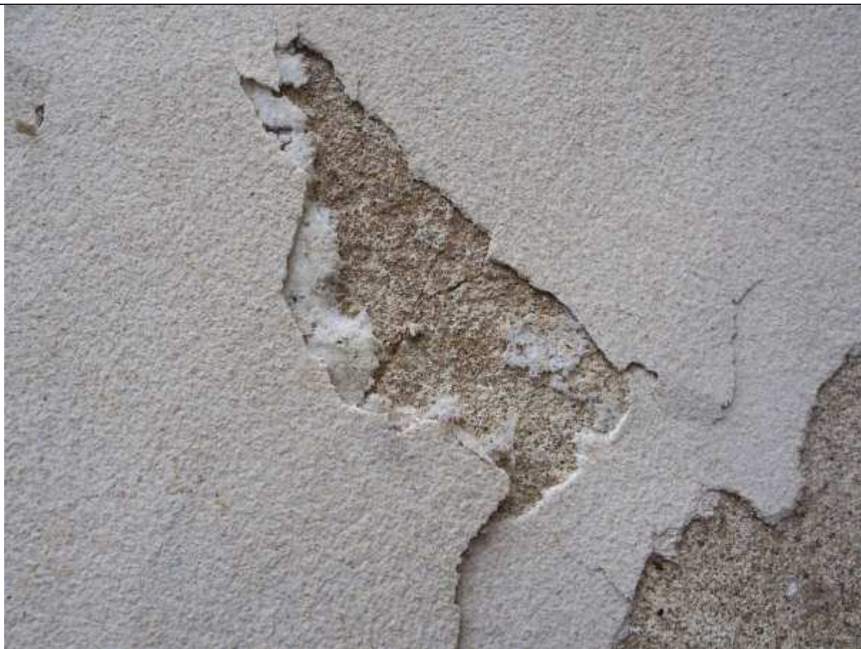
Obr. 43: Krystalizace vodorozpustných solí - soklová část jižní fasády jižního křídla
