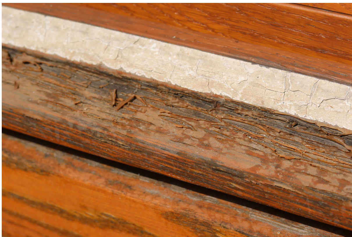
Současný stav dřevné hmoty a lazurných nátěrů - detaily
