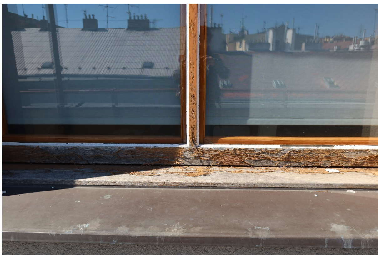
Současný stav dřevné hmoty a lazurných nátěrů -details
