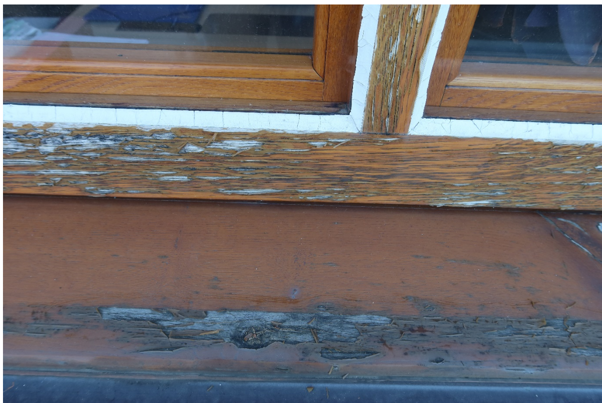
Současný stav dřevné hmoty a lazurných nátěrů včetně zasklívacího tmelu - details
