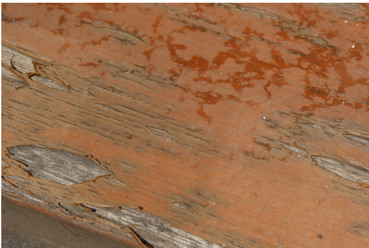
Současný stav dřevné hmoty a lazurných nátěrů včetně zasklívacího tmelu - detaily
