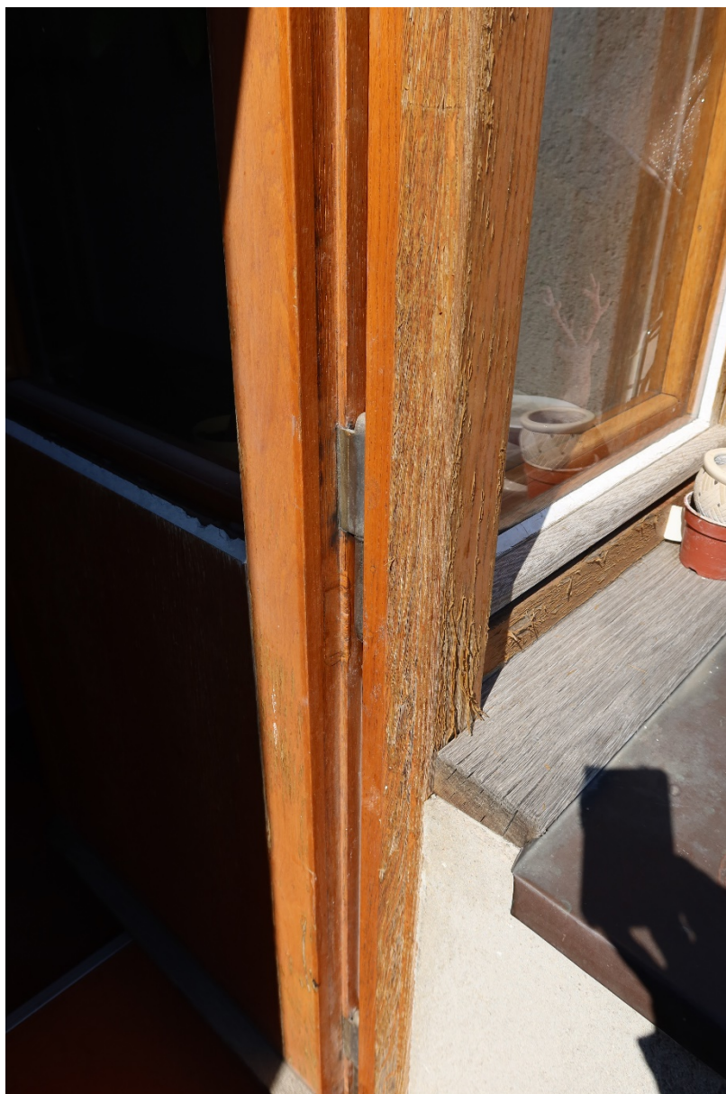
Současný stav dřevné hmoty a lazurných nátěrů -detail
