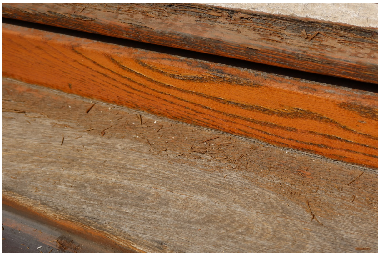
Současný stav dřevné hmoty a lazurných nátěrů - detaily
