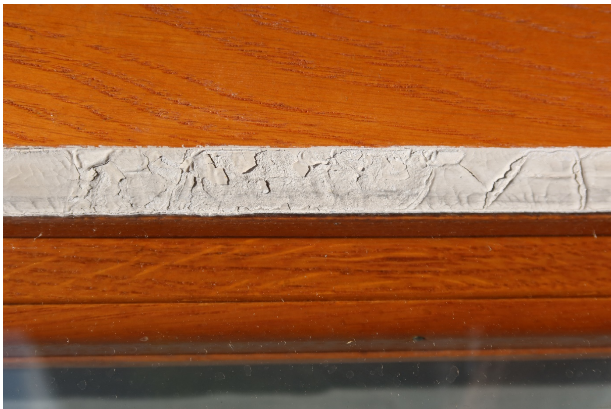
Současný stav dřevné hmoty a lazurných nátěrů včetně zasklívacího tmelu - details
