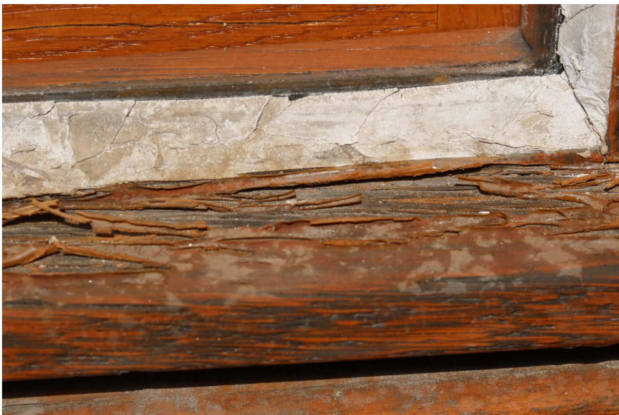
Současný stav dřevné hmoty a lazurných nátěrů včetně zasklívacího tmelu - detaily
