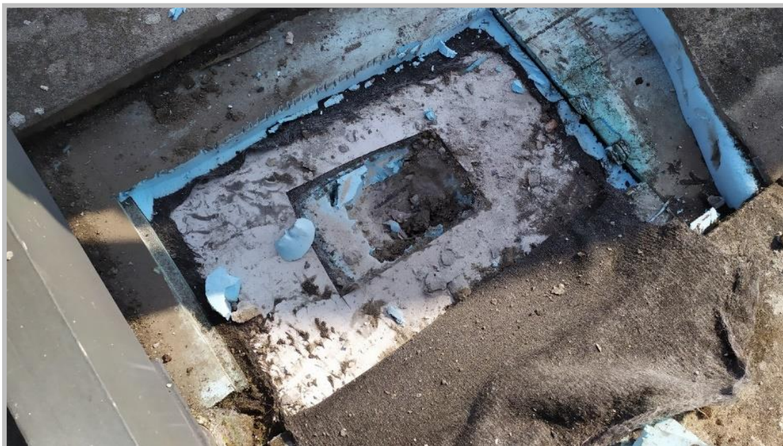
Obrázek č. 2 : Sonda do konstrukce střešního pláště
