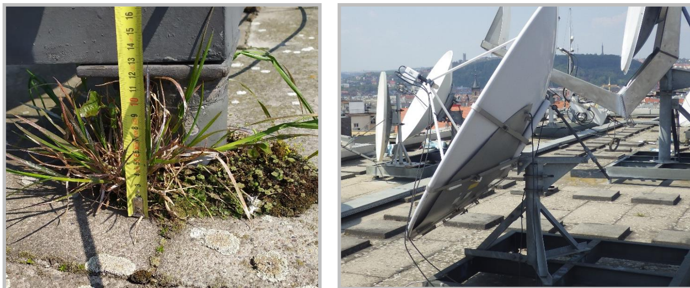
Obrázek č. 7 a 8 : Osazení technologie/ ocelové konstrukce pro satelity a antény
