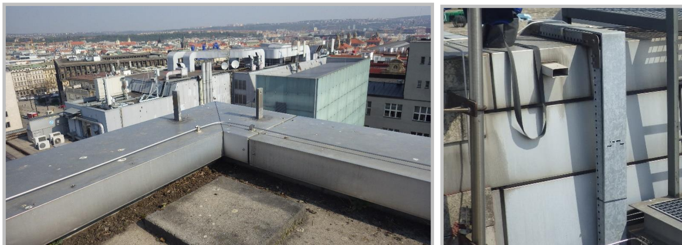
Obrázek č. 7 a 8 : Osazení technologie/ ocelové konstrukce pro satelity a antény
