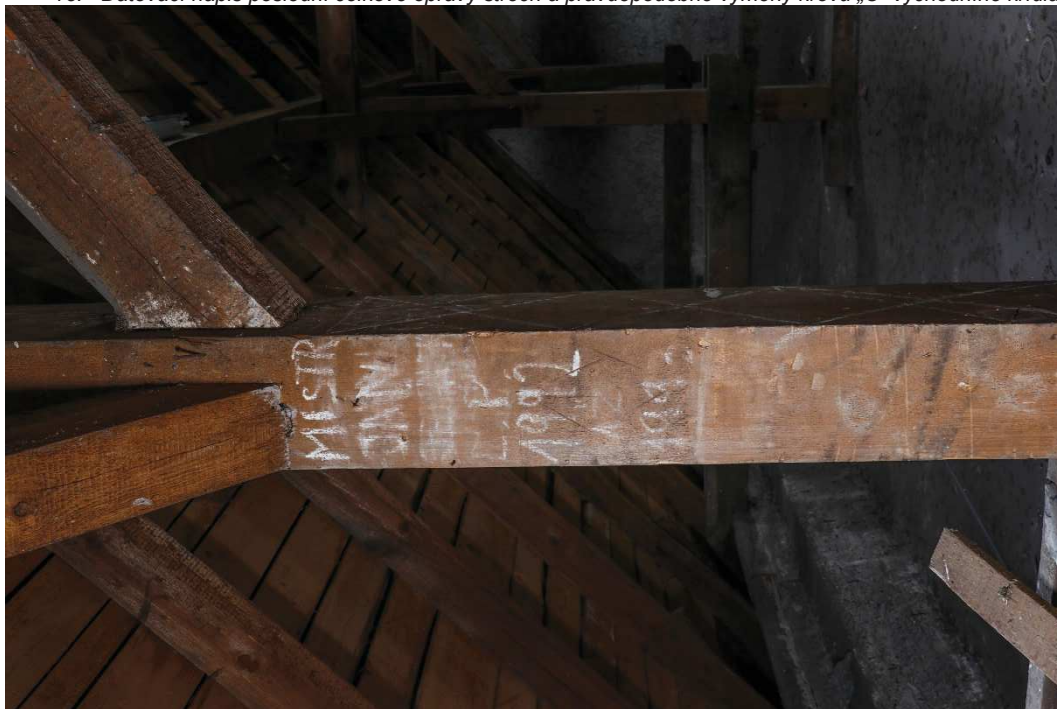
18. Datovací nápis poslední celkové opravy střech a pravděpodobné výměny krovu „C“ východního křídla
