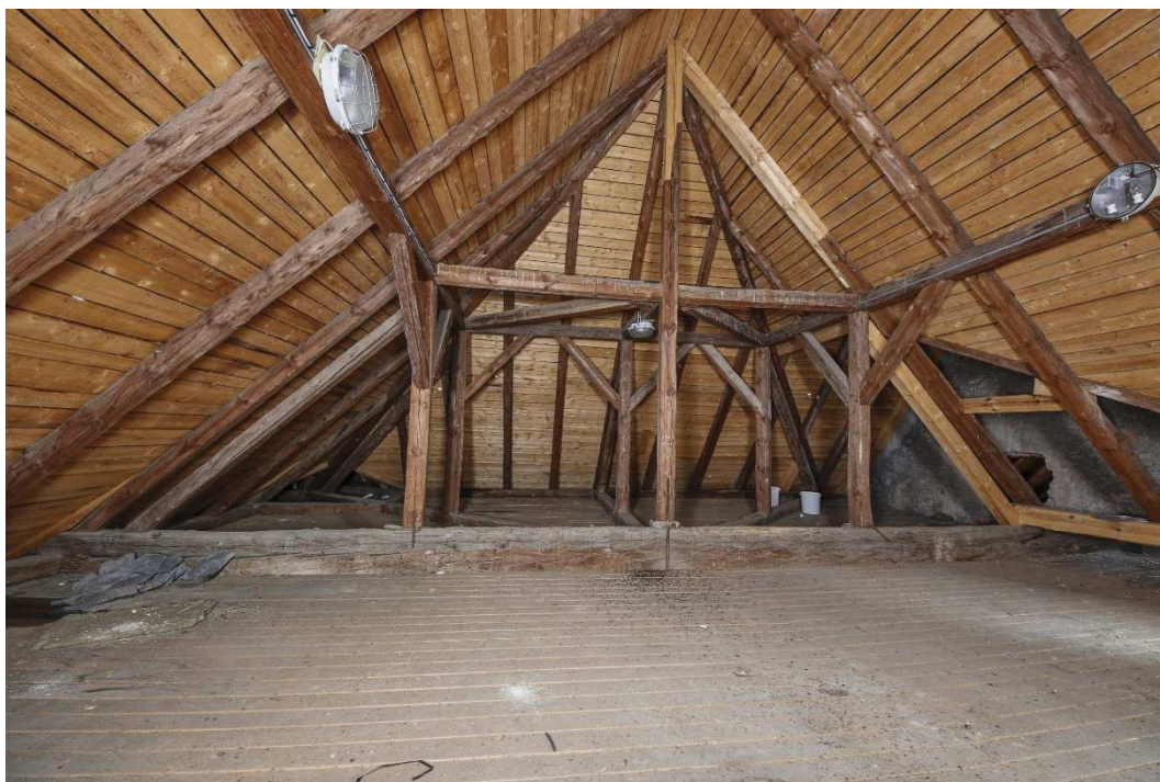
24. Pohled na hlavní plnou vazbu krovu „B“ pod špičkou valby s patrnou opravou sloupku a krokve
