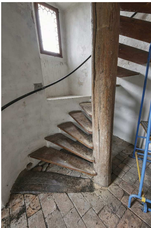
8. Spodní část točitého vřetenového schodiště ve věži
