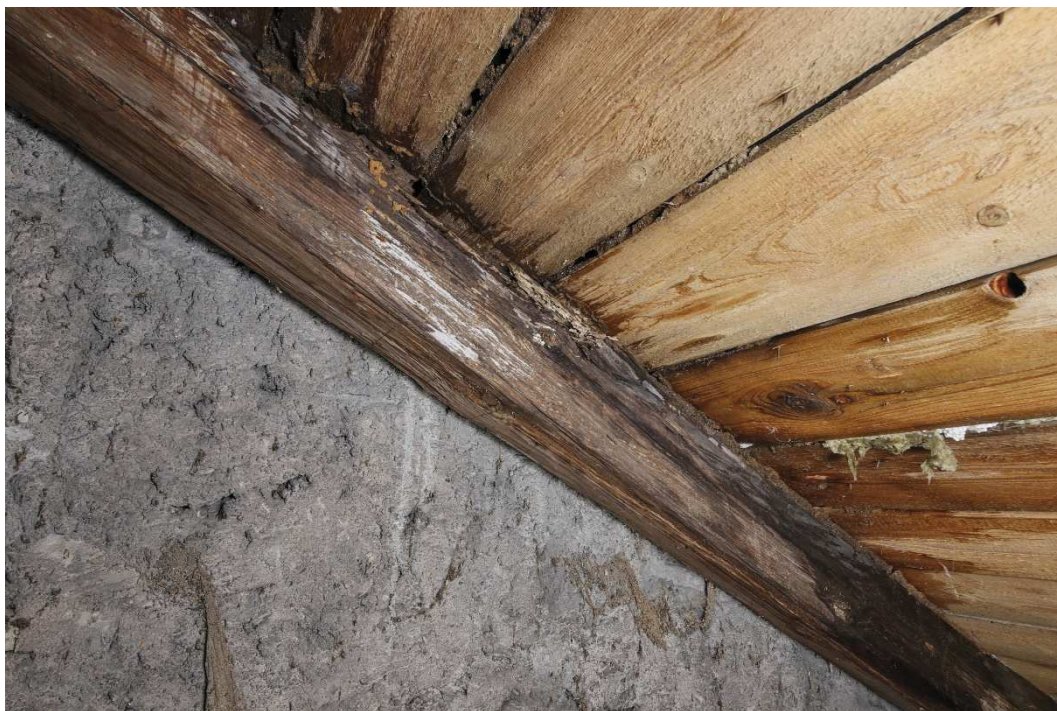
29. Krokev u požární zdi v krovu „B“, v místě zatékání silně poškozená ligninovorními houbami
