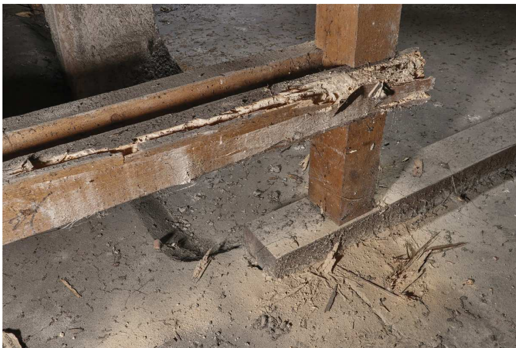
22. Kleština v krovu „A“, silně poškozená tesaříkem
