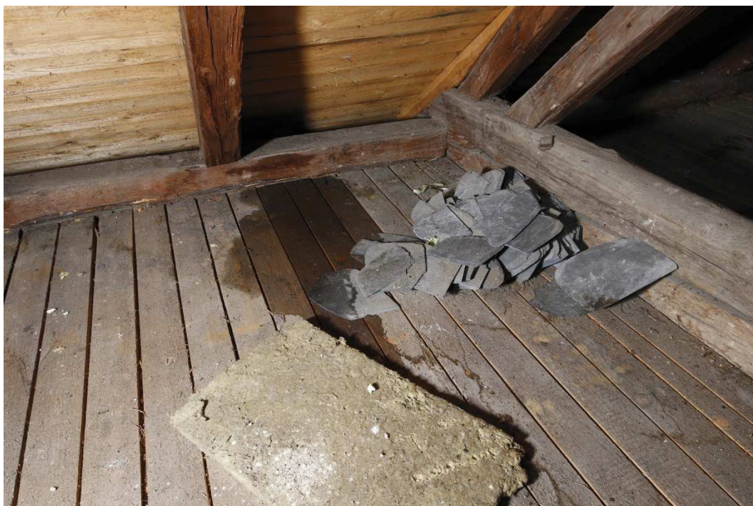
28. Intenzivní zatékání havarijní střešní krytinou v krovu „B“
