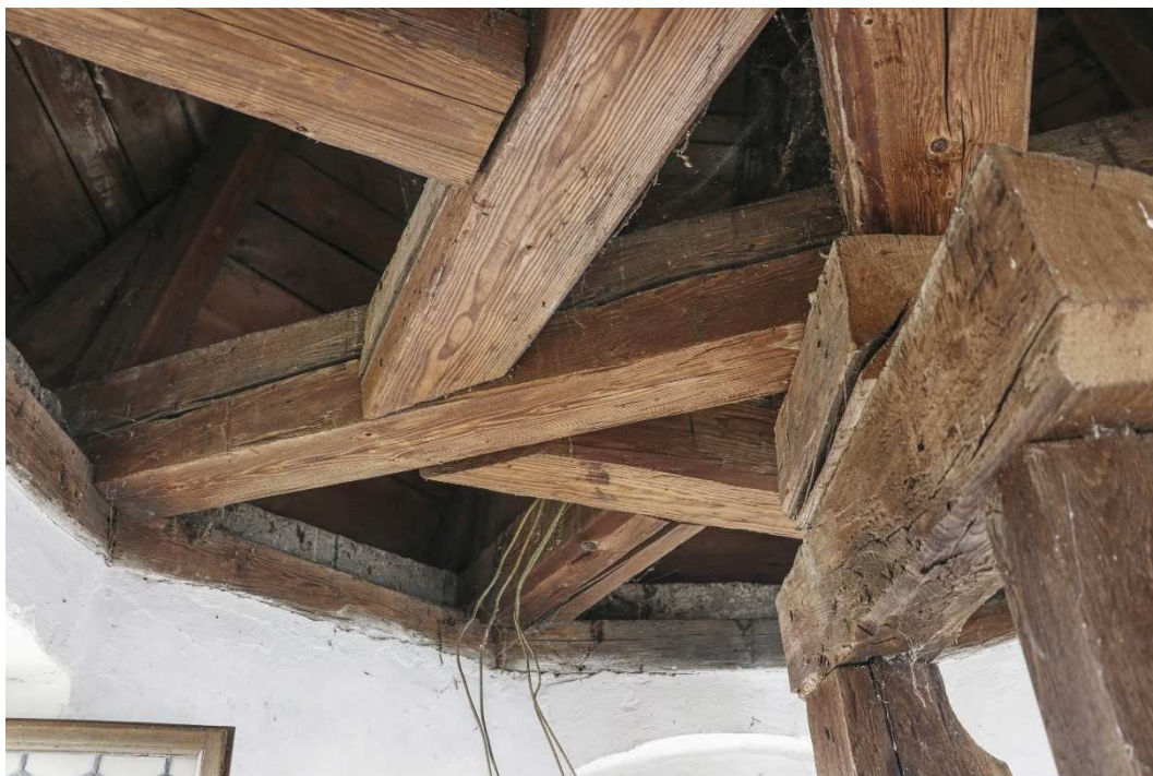
15. Detail části hvězdicového trámového roštu věžového krovu, uloženého na pozednici
