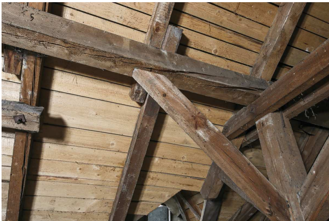
23. Výrazně levotočivá vaznice v krovu „A“ s nadměrnou torzní deformací a sníženou únosností
