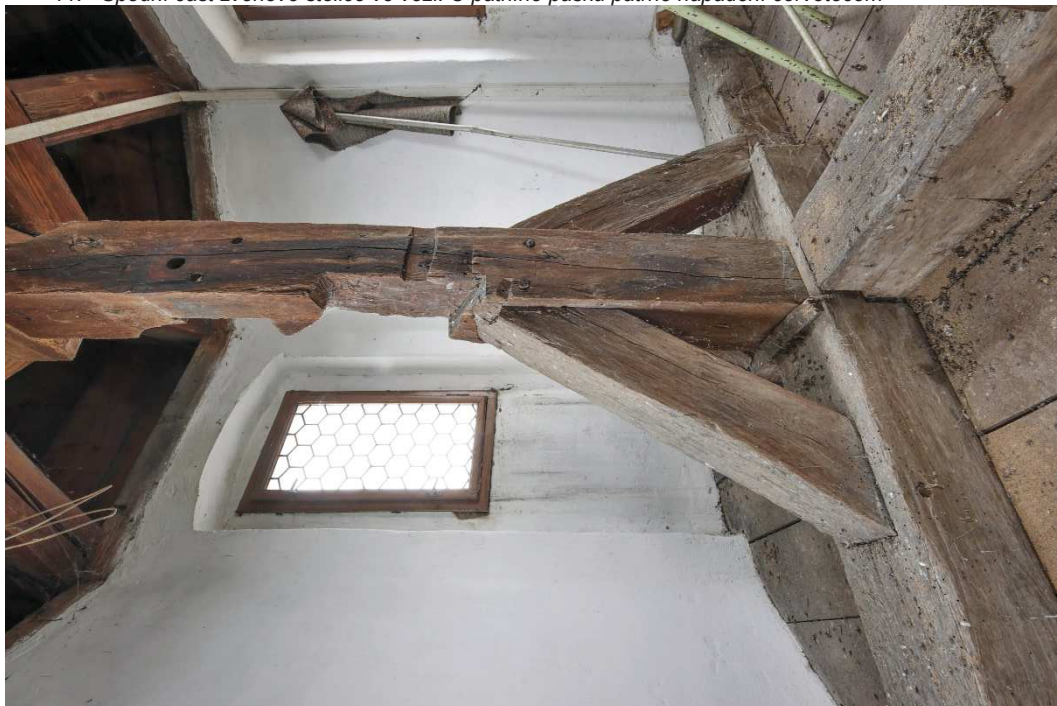
11. Spodní část zvonové stolice ve věži. U patního pásku patrné napadení červotočem
