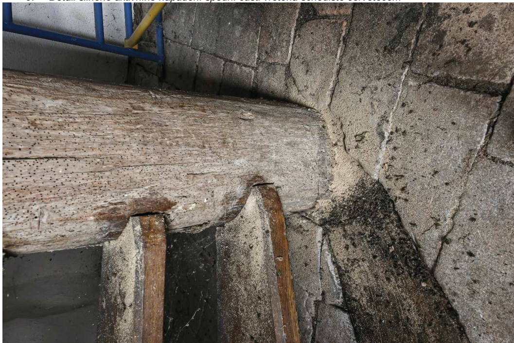
9. Detail silného aktivního napadení spodní části vřetena schodiště červotočem
