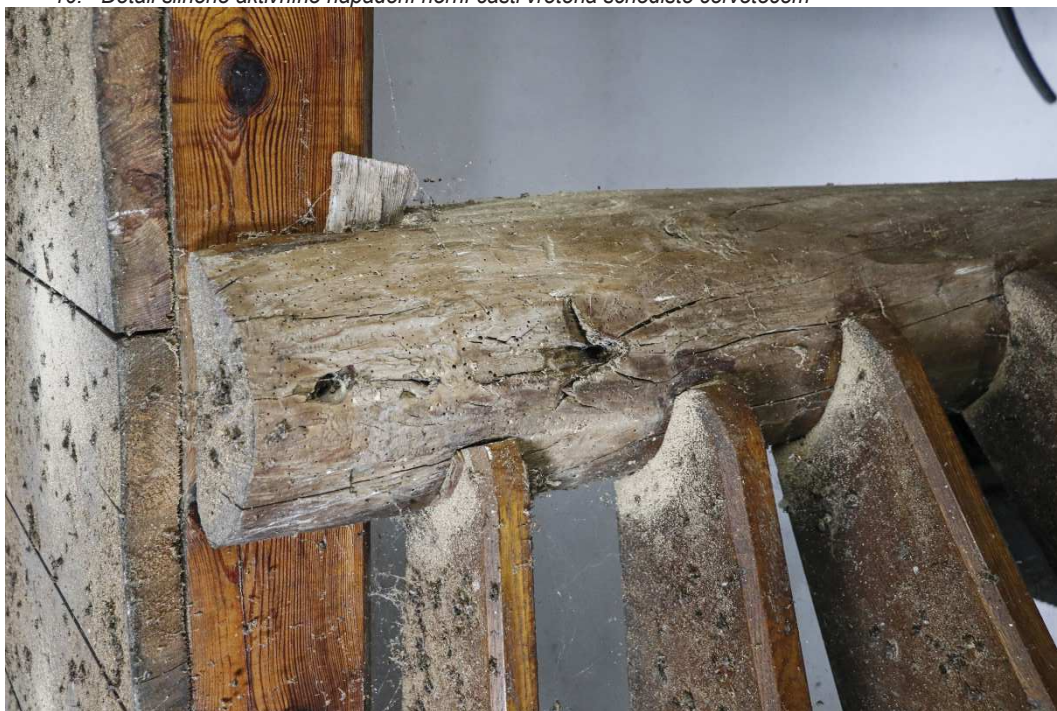
10. Detail silného aktivního napadení horní části vřetena schodiště červotočem
