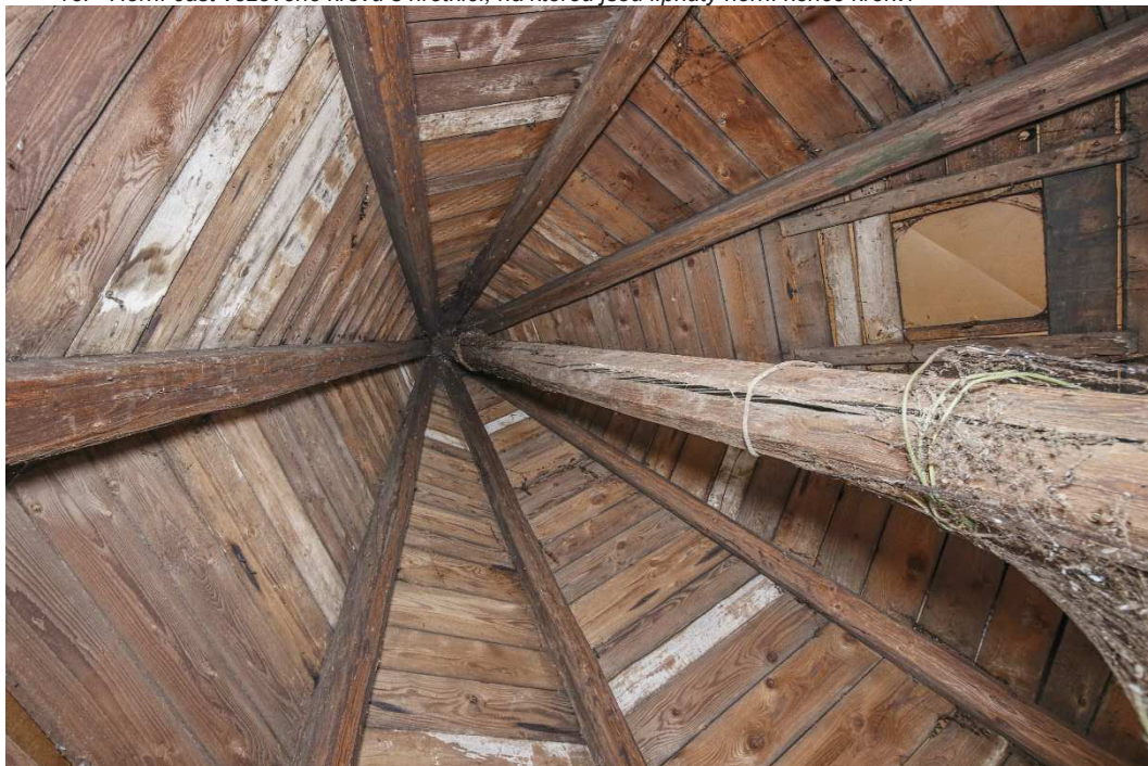
13. Horní část věžového krovu s hrotnicí, na kterou jsou lípnuty horní konce krokví
