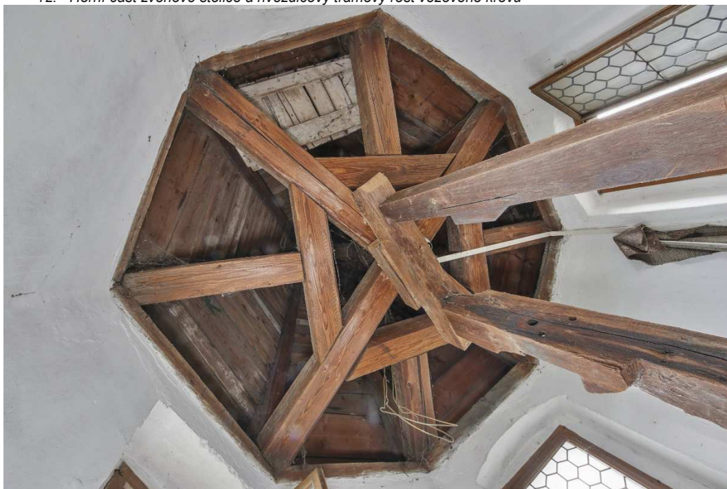
12. Horní část zvonové stolice a hvězdicový trámový rošt věžového krovu
