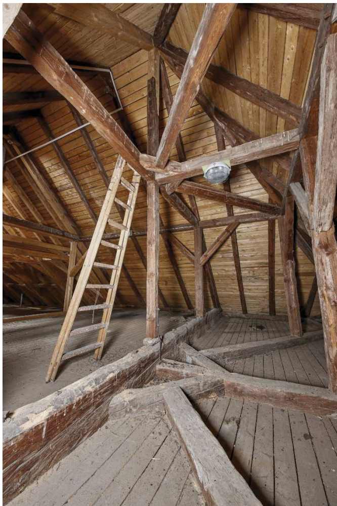
25. Pohled na hlavní plnou vazbu krovu „B“ pod špičkou valby. Dole vazný trám provedený jako zazubený trámový rošt
