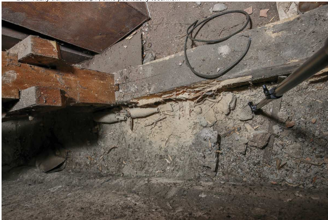
20. Vazný trám v krovu „A“, silně poškozený tesaříkem
