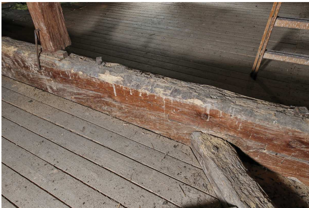
27. Vazný trám (zazubený rošt) hlavní plné vazby krovu „B“, poškozený tesaříkem
