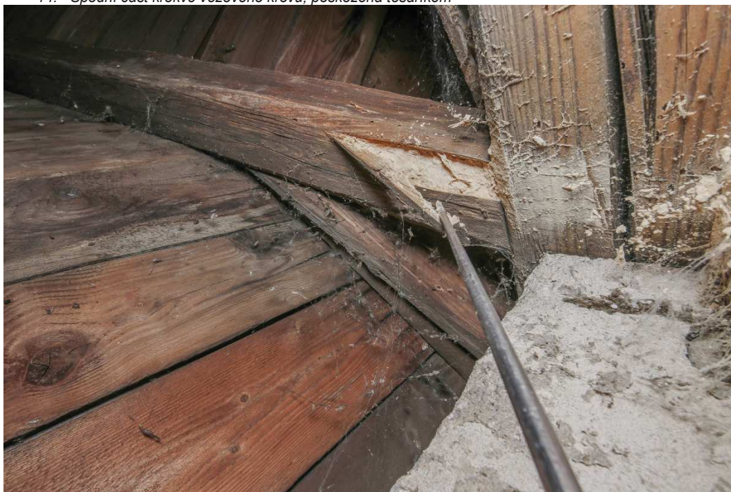
14. Spodní část krokve věžového krovu, poškozená tesaříkem
