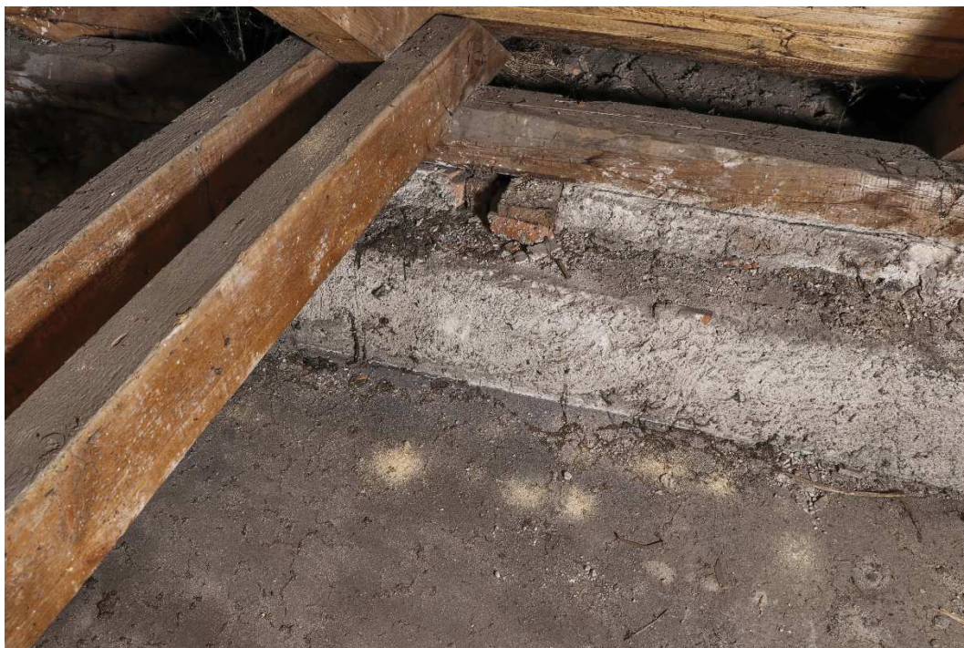
21. Charakteristické znaky aktivity tesaříka v krovu „A“
