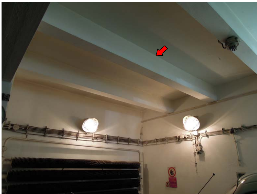
Foto č.5.....Železobetonový monolitický trémový strop
