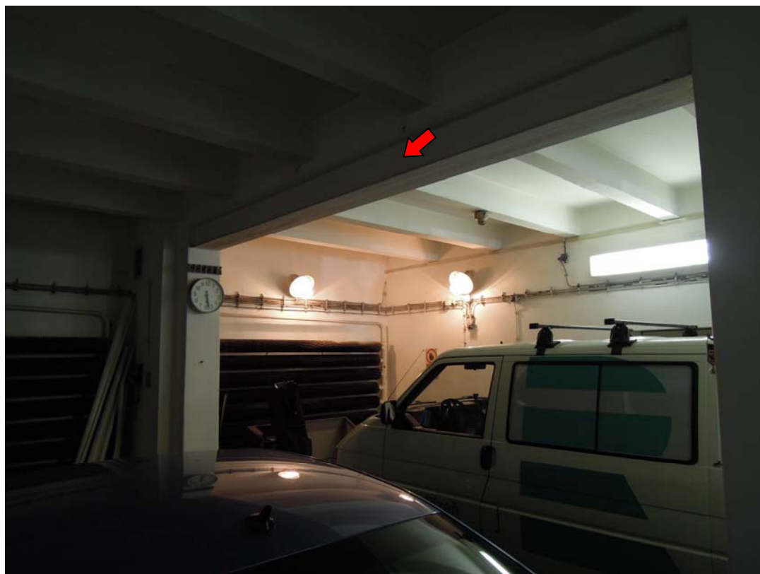
Foto č.4..... Stávající ocelový průvlak
