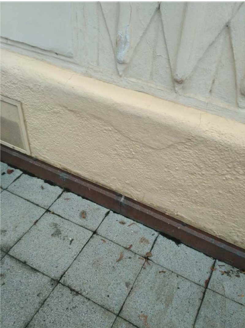
Detail 12. - řešení návazností omítka/schodišťový stupeň
