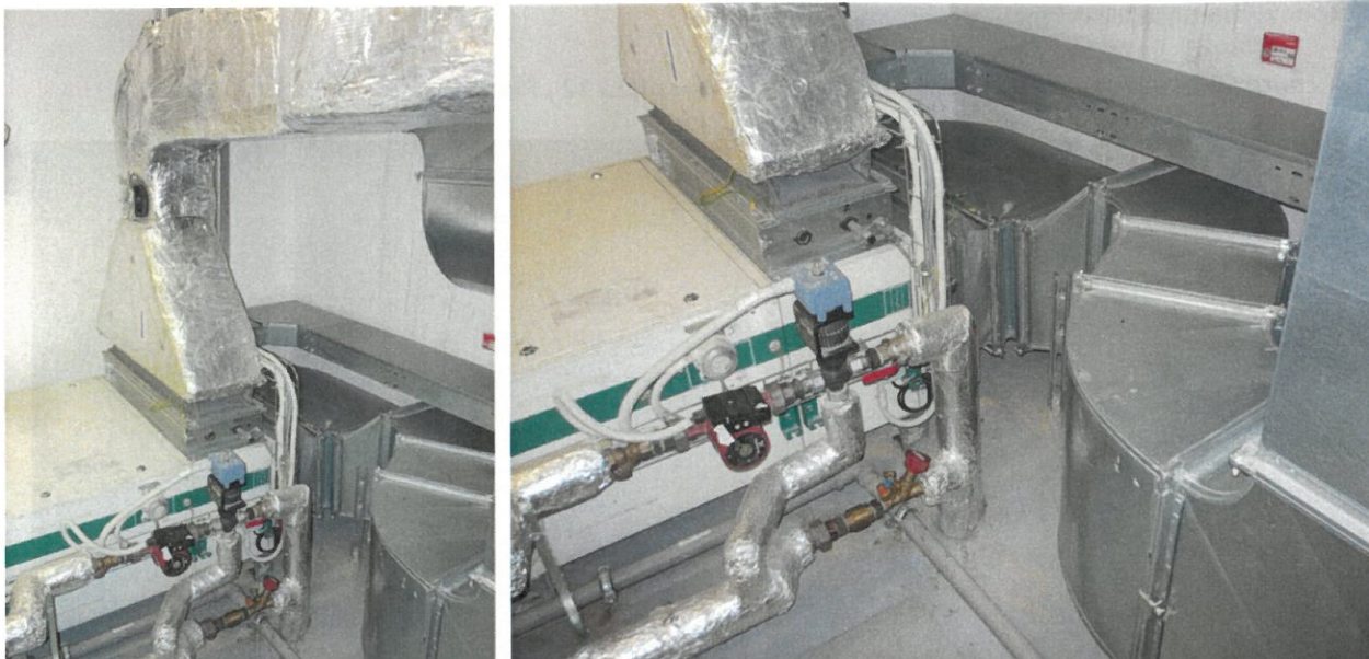
Stávající stav – pohled do prostoru za VZT jednotkou. / Stávající periferie MaR a čerpadlo na větvi teplé vody.
