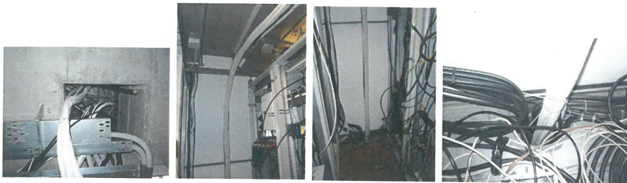
Pohled na trasu potrubí chladiva a komunikační kabeláže ze střechy směrem k vnitřním jednotkám v 6. NP. Mezi podlahou v 8.NP a stropem v 6.NP tj. cca 5 metrů je rozvod veden v kovové chrániče spolu s další kabeláží.
