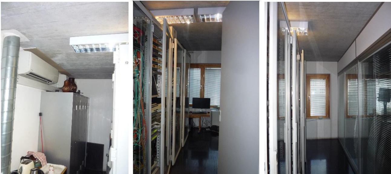
Pohled do uliček mezi stojany s technologií – v místě stávajících dvou vnitřních nástěnných jednotek bude nově umístěna jedna podstropní kanálová jednotka napojená na čtyřhranné potrubí s izolací pro distribuci chladného vzduchu do uliček v přepojovači. Druhá podstropní kanálová jednotka napojená na čtyřhranné potrubí bude umístěna uhlopříčně přes místnost přepojovače pod stropem v poslední uličce viz. třetí foto.
