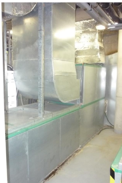
Pohled na zadní část VZT jednotky a odstup od nosného sloupu, napojení potrubí VZT
