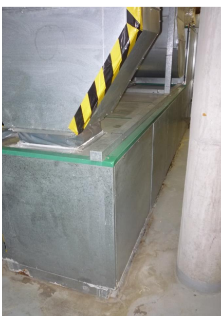
Pohled na zadní část VZT jednotky a odstup od nosného sloupu, napojení potrubí VZT
