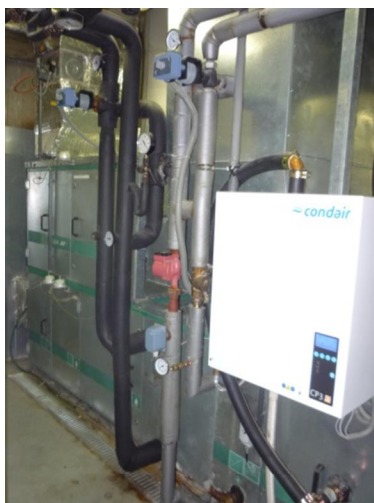
Rozvody tepla a chladu, zvlhčovač
