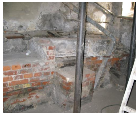
zbytky zděných konstrukcí
