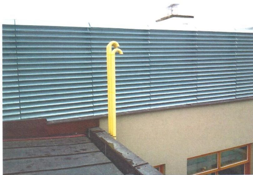
Provést po spojení trubek
