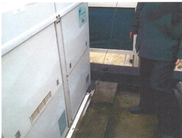
Provést do po spojení klimatizací u vstupu na střechu
