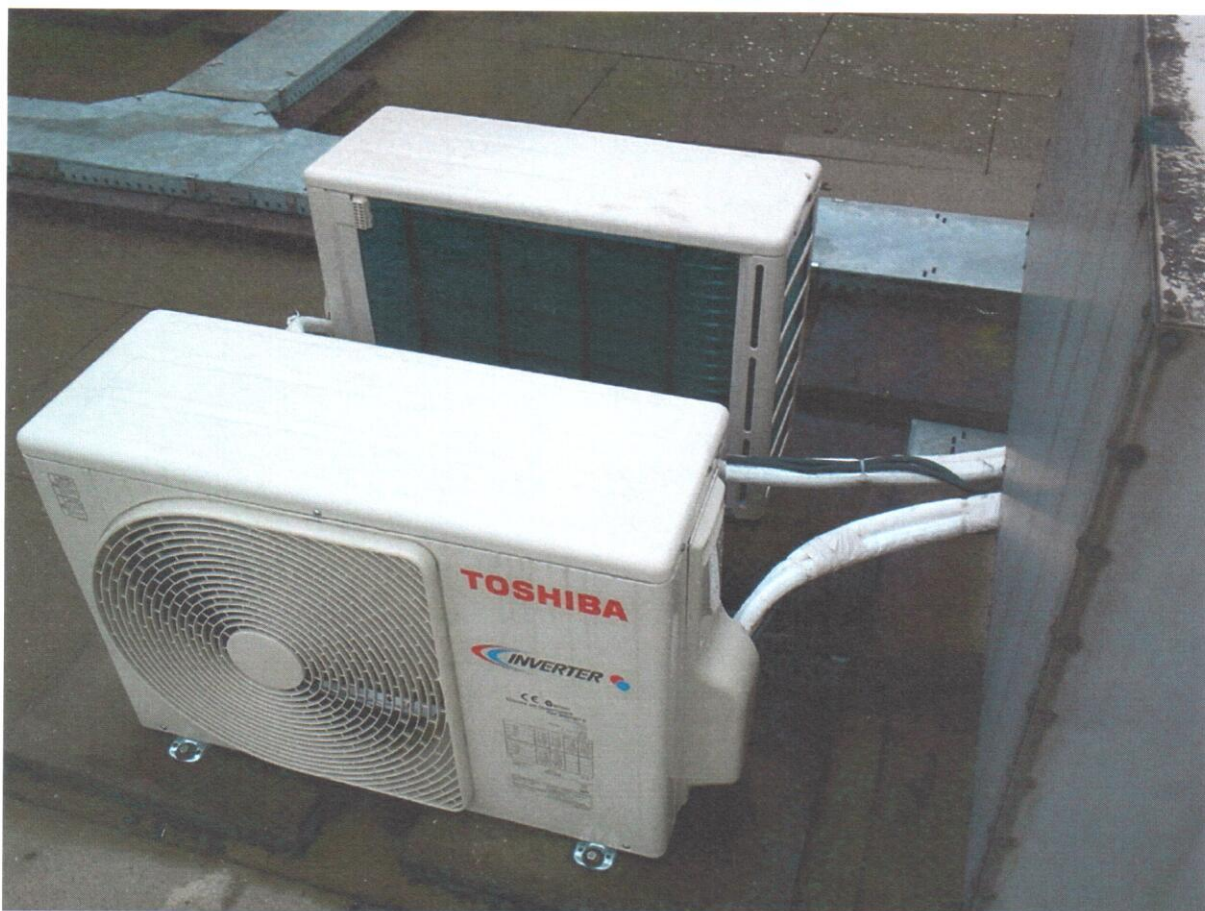
Provést do po spojení klimatizací
